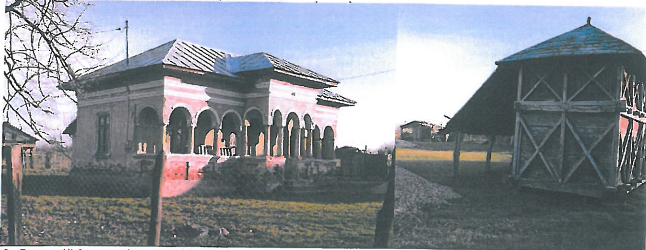
2. Gospodărie cu valoare ambientală/ arhitectură tradițională, DC 302
